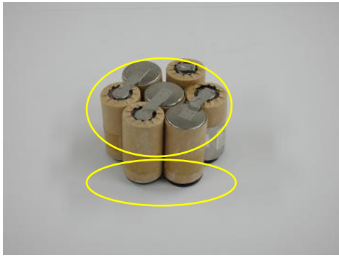
(電池端子連結部露出)
